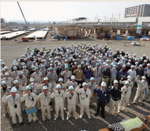
応急住宅建設現場と応急住宅建設チーム
