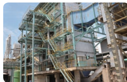
RPI社の 木質バイオマス 発電プラント
