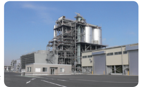
川崎バイオマス発電(株) 木質バイオマス発電 プラント
